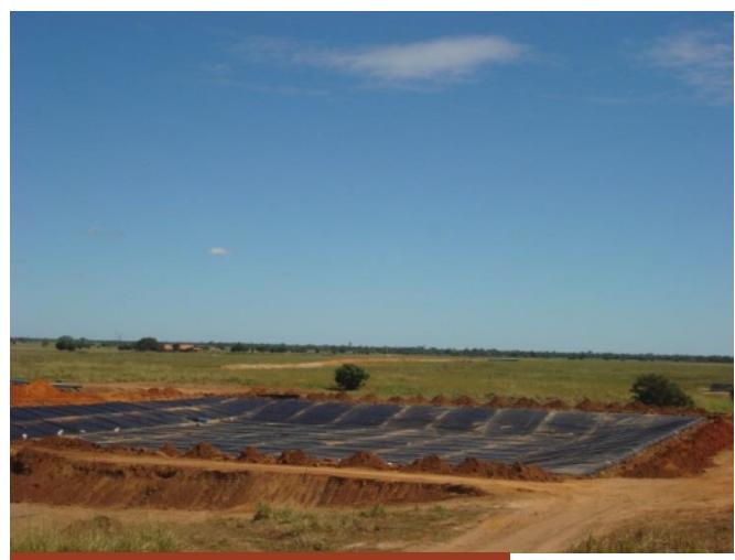
Figura 4. Serviço de instalação de TechGeo PEAD tanque de armazenamento de água para irrigação finalizado.
