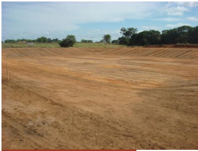
Figura 1. Áreado tanquepronta para recebimento e instalação da TechGeo PEAD.
