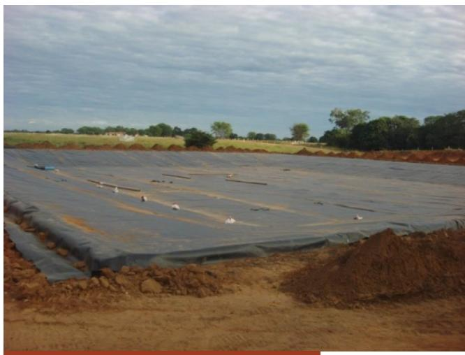
Figura 3. Área da lagoa impermeabilizada. Detalhe para a vala de ancoragem, que irá fazer a fixação da geomembrana.
