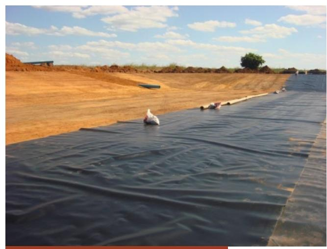
Figura 2. Instalação da TechGeo PEAD.
